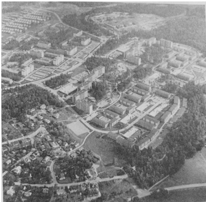
Gottsunda i början av 1970-talet. Centrumanläggningen under byggnad i bildens övre del. Foto Sture Foto.
